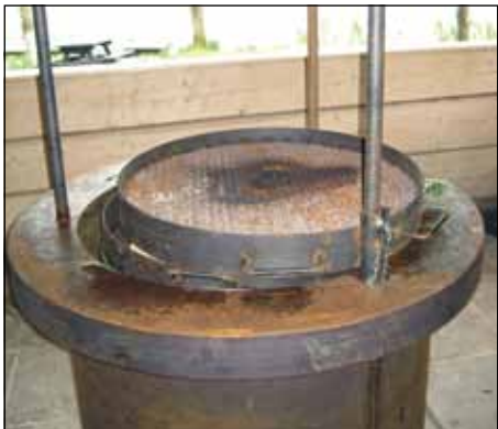
Här finns utrymme att grilla din favoriträtt. Alldeles strax kommer plexiglasen på plats så det kommer att bli ombonat och dragfritt inne i huset.
