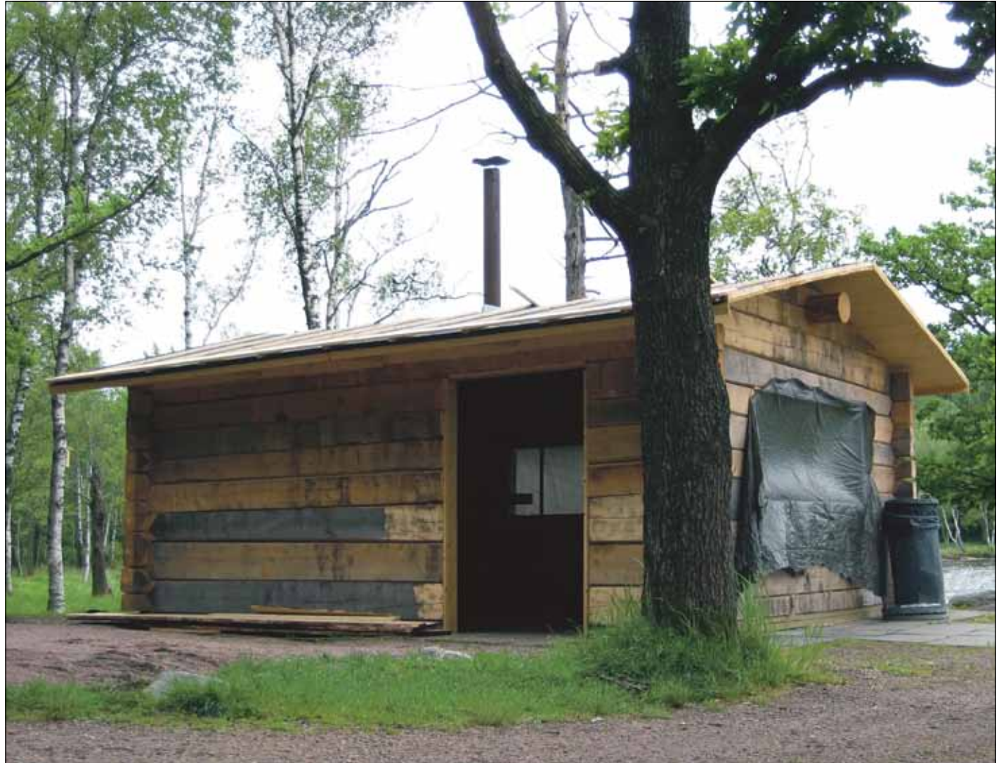
SNART FÄRDIGTSTÄLLT – grillen och skorstenen på plats, takpappen, läkten och sedan spåntaket. Om någon vecka eller två är bygget klart. Det handlar om den nya raststugan några hundra meter från Bertilssons stuga.
